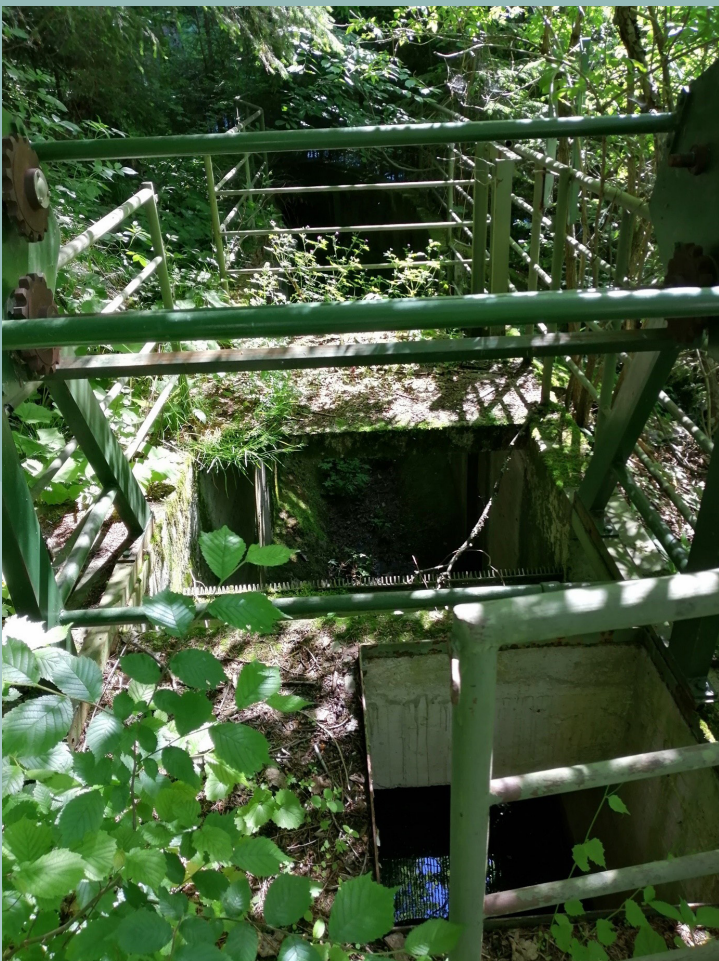
Zapornica za vodo pri zajemu vode za hidroelektrarno. Zapuščenosť se kaže tudi v preraslosti z bujno vegetacijo. (avtor: Adam Gabrič)
